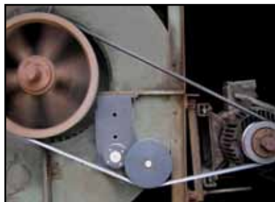
RT3000 e Polia Roldana PowerMax ™ instalada em uma unidade de movimento de ar
